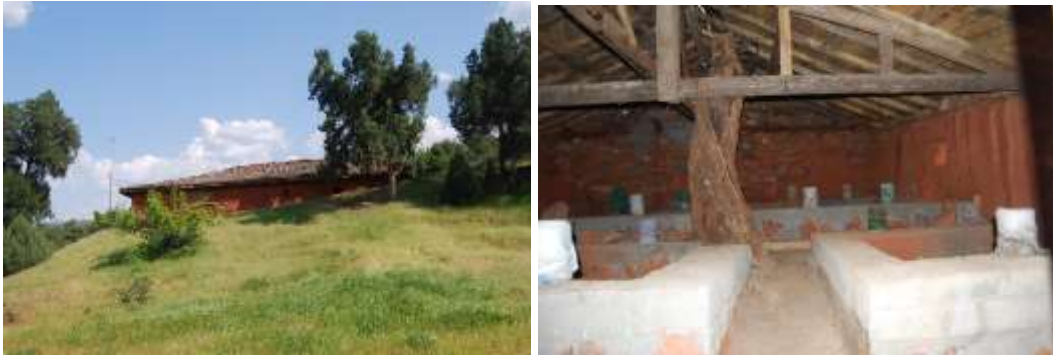
Görsel 110, 111: Türbenin dışarıdan ve içeriden görünüşü
