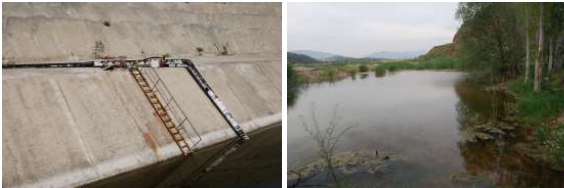
Görsel 61- 62: Barajdan özel izinle alınan suyun borusu ve Pınarbaşı adı verilen su kaynağı
